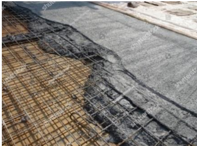
Заливання арматурного каркасу бетоном
