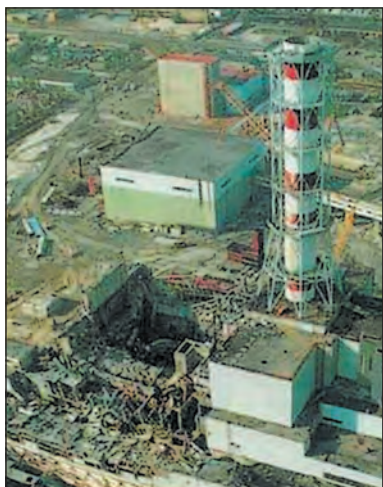
Зруйнований 4-й енергоблок Чорнобильської АЕС. 1986 р.
