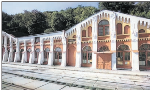
Машинний будинок нижньої станції водогону в Києві. XIX ст.
