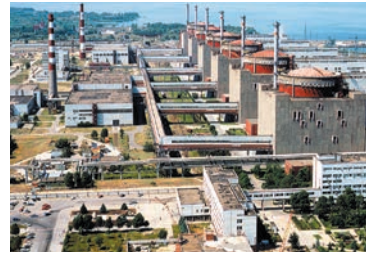
Рис. 27.3. Запорізька АЕС — найбільша атомна електростанція Європи, на ній працює 6 атомних енергоблоків
