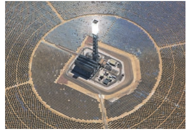
Рис. 10. Одна з найбільших сонячних електростанцій у світі — «Айванпа» (США, Каліфорнія). 173 тис. дзеркал відбивають сонячне світло та спрямовують його на вершини трьох веж, де встановлено котли з водою. Гаряча пара надходить на лопаті турбін, установлених усередині веж
